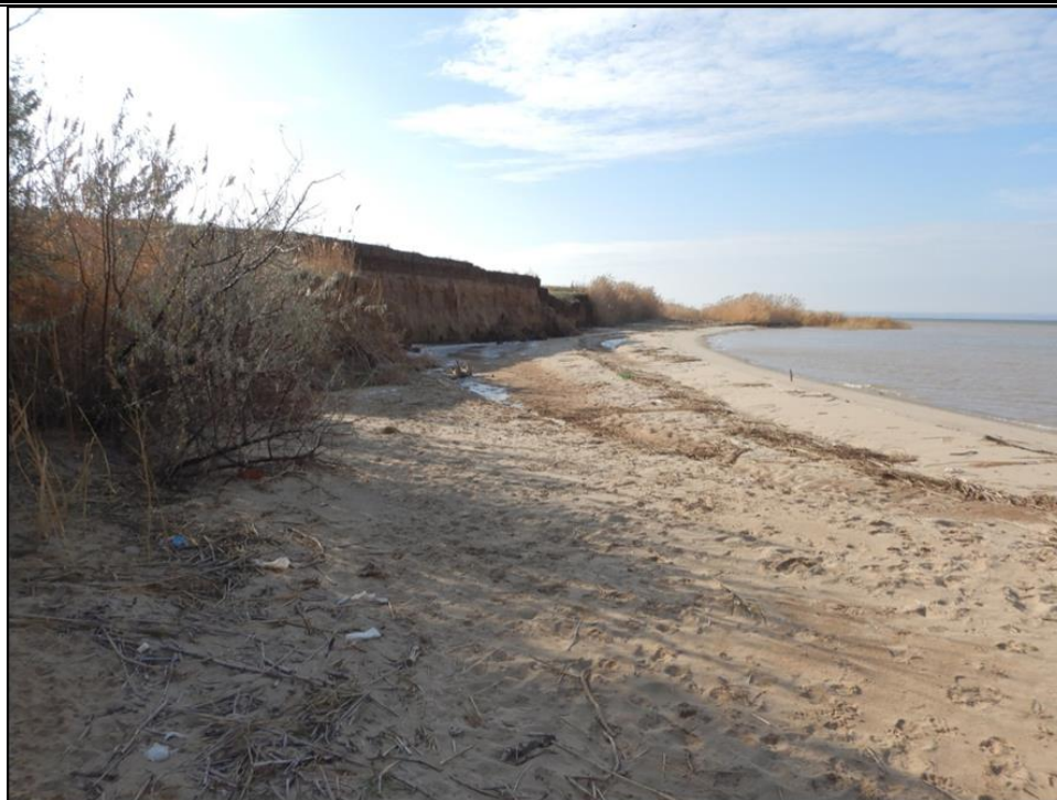
Фото 12.1. Створ водозабора из Волгоградского водохранилища
